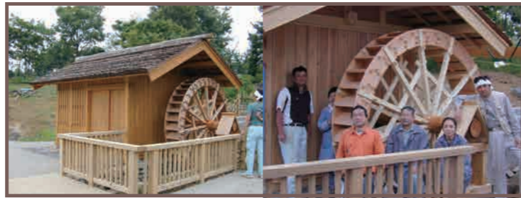
水車小屋 施工 梅沢工務店株式会社 水車 施工 原製作所
